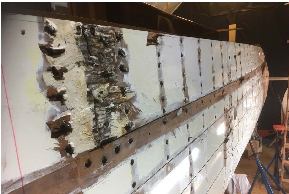
Det här blev effekten av att skrovet "hängde sig" En sk "spännings-korrosion", där lasken
