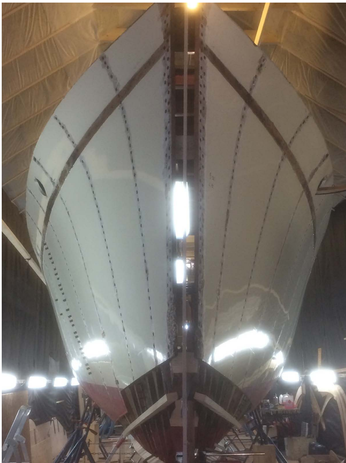
För att åtgärda förstäven så handbilas de gamla delarna bort under två dagar. Alla skruvar demonteras i bordsändar. Den gamla stäven kommer att monteras ny i ett stycke. I detta läge är båten delad på längden och skrovsidorna hålls ihop av 8 stycken 22 mm plywoodskivor samt kätting med vantskruvar. (Foto: Tony Duda)
