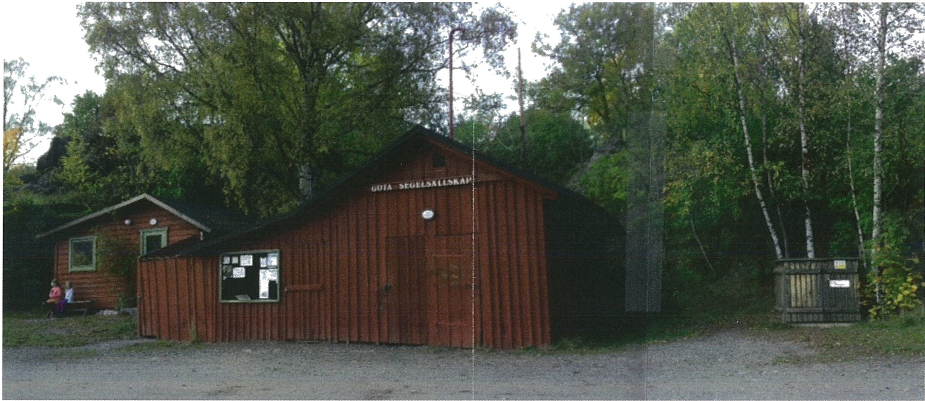
Ursprunglig byggnad - vy från söder
