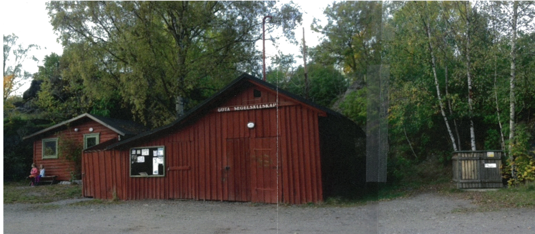
Ursprunglig byggnad - vy från söder
